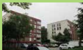
Résidence QUEBEC 180 logements - Amiens
