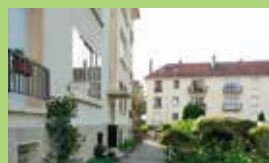
Résidence ABLADENE 36 logements - Amiens
