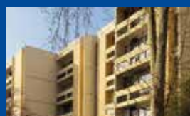
Résidence LES BRUYERES 59 logements - Nogent-sur-Oise
