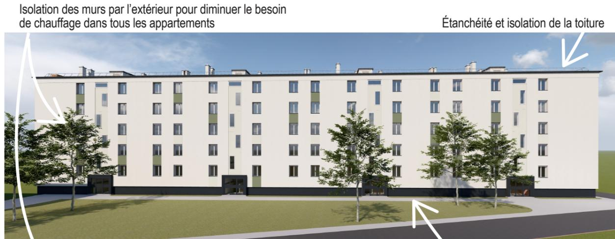
Isolation des murs par l'extérieur pour diminuer le besoin de chauffage dans tous les appartements
