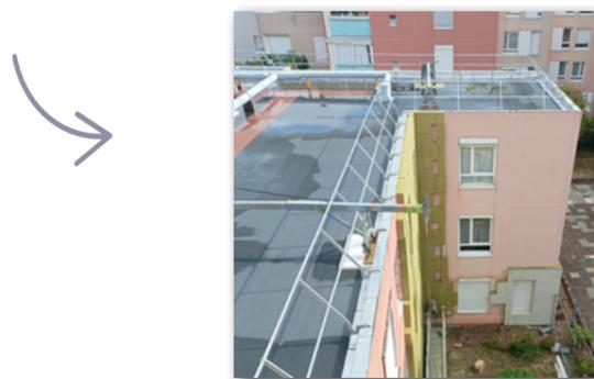
Sur les toitures rénovées dans le cadre du projet : installation de garde-corps « classiques » inclinés pour moins de visibilité.
