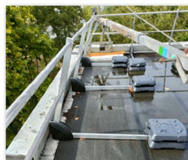
Sur les toitures précédemment rénovées : pose de garde-corps « autoportant » avec un contre poids.
