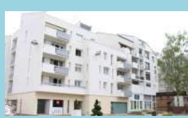
Résidence ALBERT DUGUÉ 75 logements - Creil
