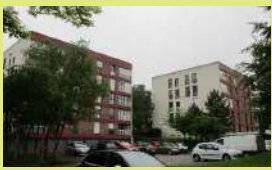
Résidence QUÉBEC 180 logements - Amiens
