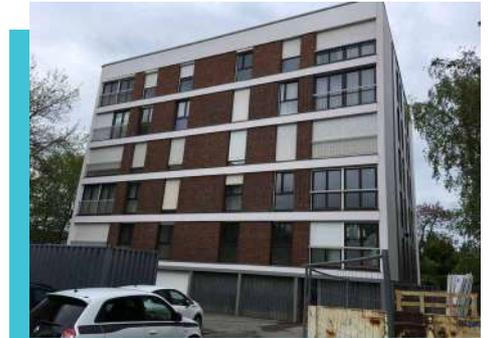
Nettoyage des façades briques et mise en peinture des bandeaux béton
