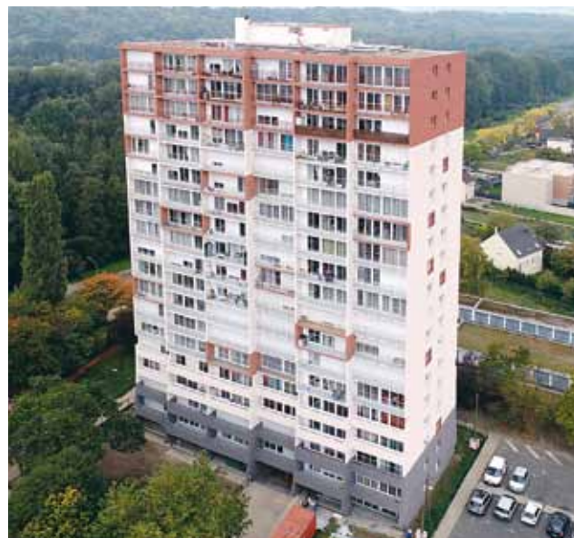
Les travaux d'isolation de la résidence Hélène (ici, l'un des édifices) doivent permettre des économies d'énergie de plus de 40 %.
